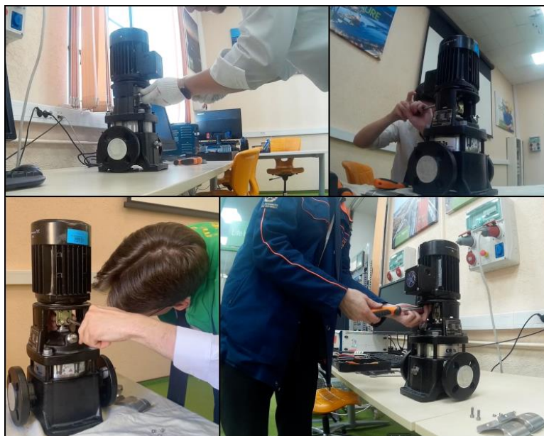
Рис. 1. Выполнение ТОиР центробежного насоса Grundfos
